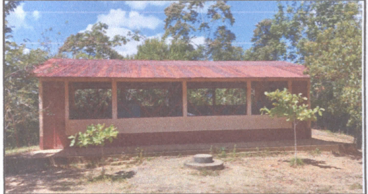
Foto 2: Sustitución de láminas, por láminas troqueladas (aula de segundo y tercero)
