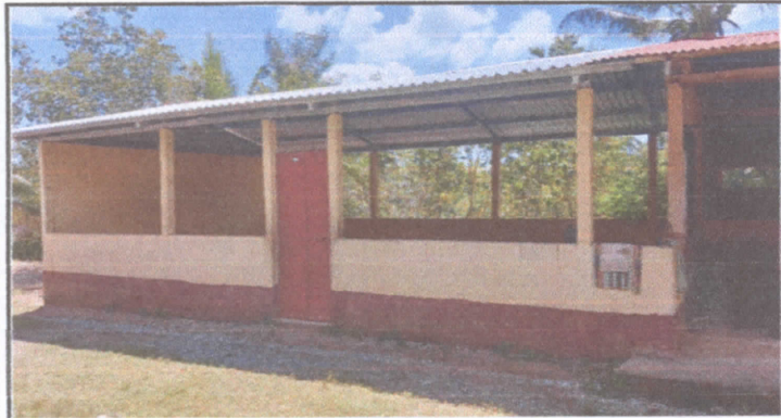
Foto 3: Fabricación e instalación de balcones de metal (aula de sexto)
