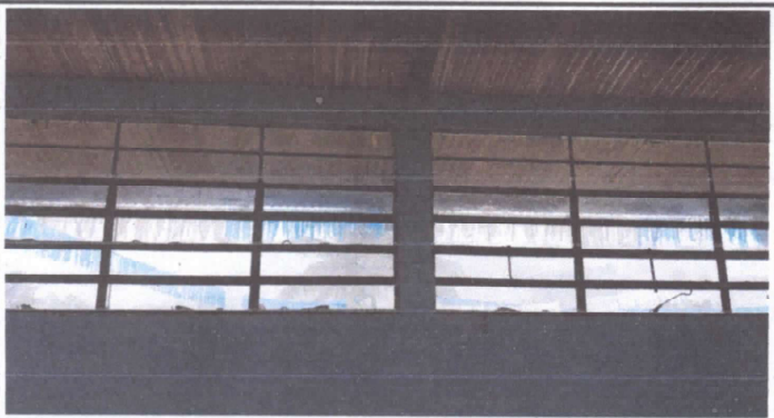
FOTO 3: Fabricación e instalación de balcones de hierro en ventana
