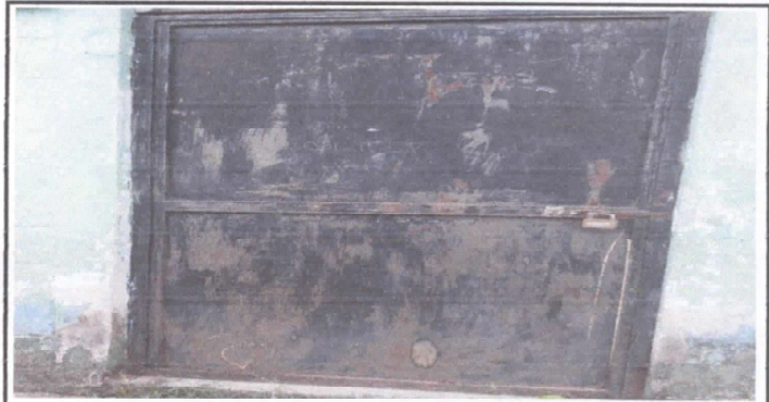
FOTO 2: Sustitución de puerta
