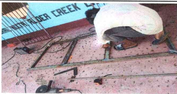
Foto 5: Éste es la elaboracion de las puertas metálicas.
