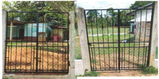
Foto 2. Fabricación e instalación de los 2 portones de metal de ingreso finalizados.
