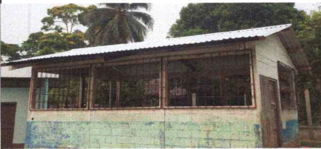
Foto 3. Sustitución de lámina realizada en su totalidad.
