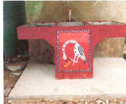
Foto 4. Sustitución de pila de cemento de dos lavadero finalizado.
