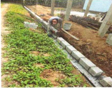
Foto 1. colocación de hiladas de block
