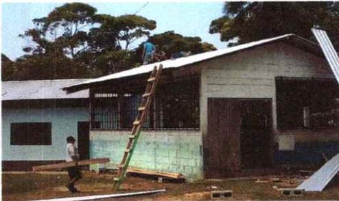
foto 5. Colocación de las nuevas láminas sobre el techo de la cocina.
