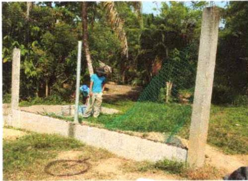
Foto 3. Colocación de la malla galvanizada con forro verde.
