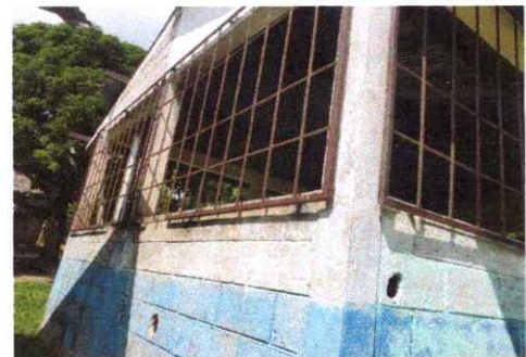
foto 6. Balcones de metal deterioradas.
