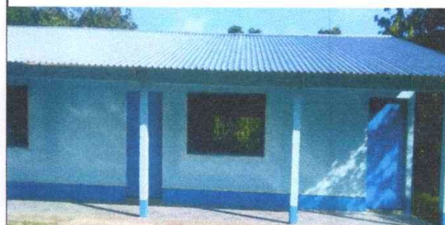
Foto 2: techado terminada de la escuela.
