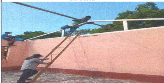
Foto 3: Soldadura de costanera de la escuela menciona.
