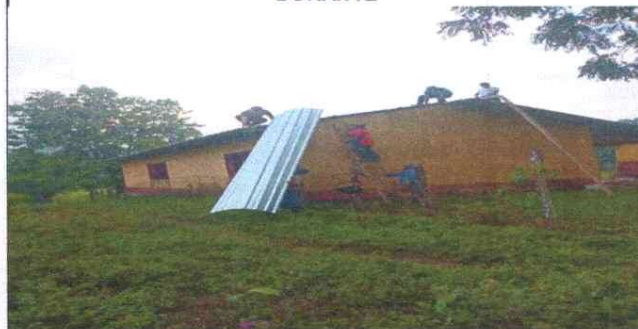
Foto 4: Instalación del techado.
