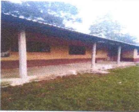
Mantenimiento de pintura
