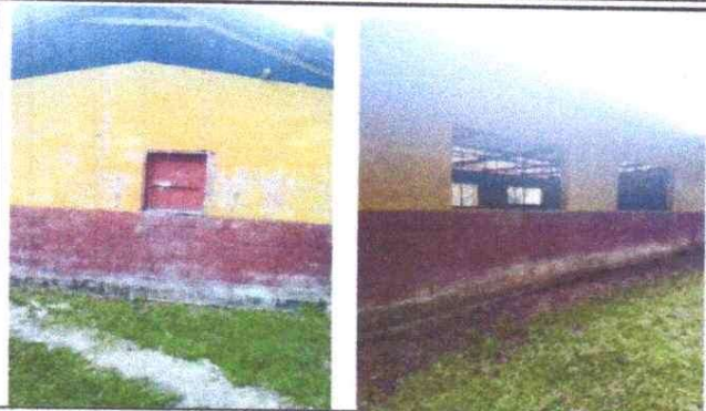
Mantenimiento de ventanas y balcones
