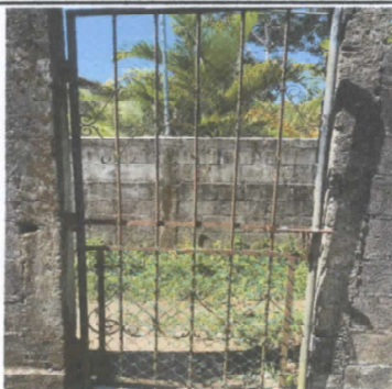
FOTOGRAFIA 5: Mantenimiento de porton.
