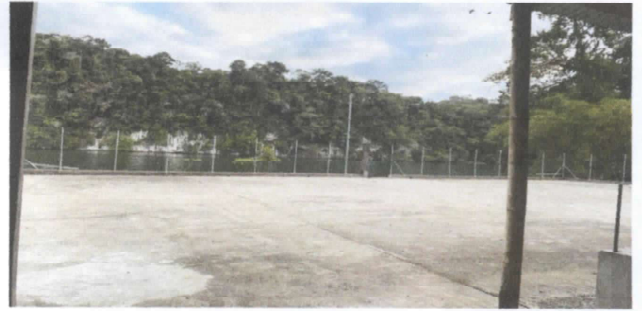
FOTOGRAFIA 8: Mantenimiento de muro perimetral
