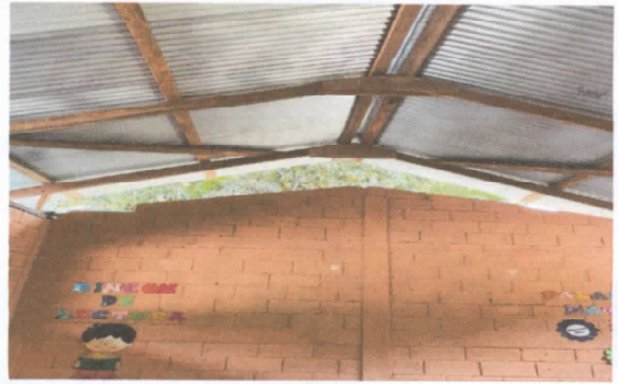
FOTOGRAFIA 2: Sellado de aula del nivel preprimario
