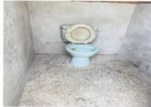
FOTOGRAFIA 4: Sustitucion de baño.
