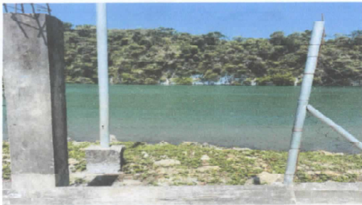
FOTOGRAFIA 9: Mantenimiento de muro perimetral
