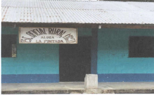
FOTOGRAFIA 7: Mantenimiento de puertas
