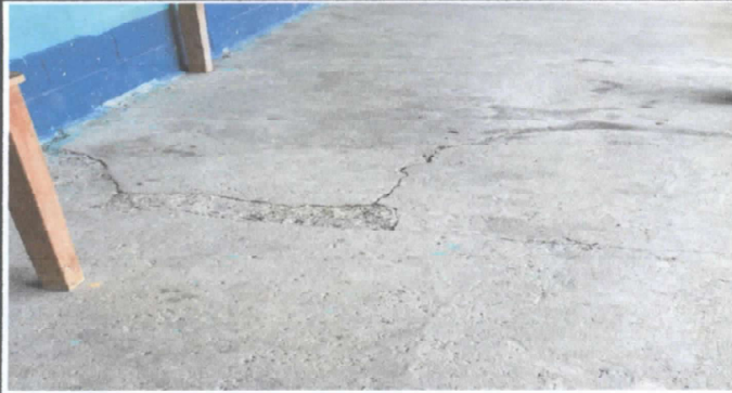
FOTOGRAFIA 1: Sustitucion de piso en el aula
