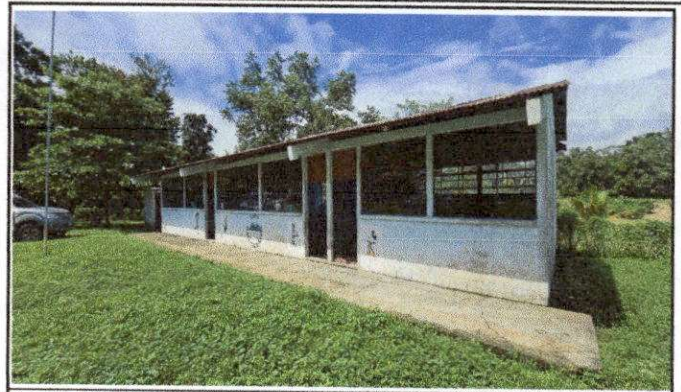
Foto 2: REMOZAMIENTO DE ESCUELA EN AULAS ESTRUCTURA METALICA Y TECHO
