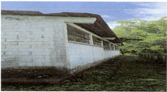
Foto 6: .REMOZAMIENTO DE TECHO DE LAMINA
