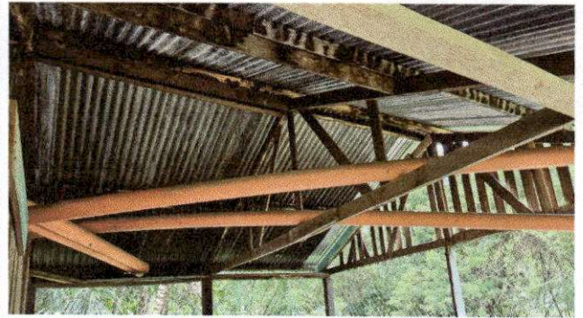
Foto 7: REMOZAMIENTO DE ESTRUCTURA METALICA
