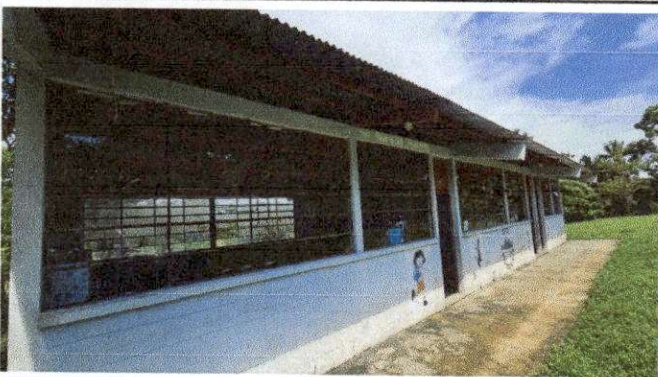
Foto 3: REMOZAMIENTO DE TECHO EN AULAS
