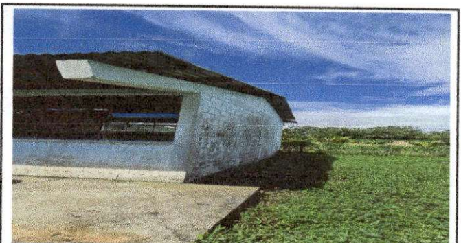
Foto 6: REMOZAMIENTO DE ESTRUCTURA METALICA EN AULA
