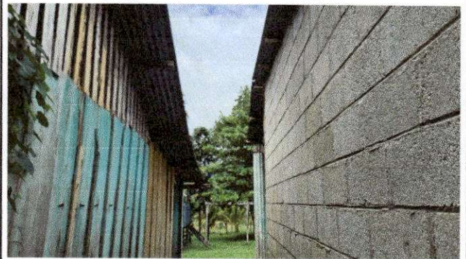
Foto 10: REMOZAMIENTO DE LAMINA
