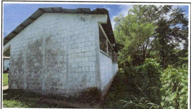
Foto 4: REMOZAMIENTO DE LAMINA SUMINISTRO E INSTALACION DE LAMINADA TROQUELADA.
