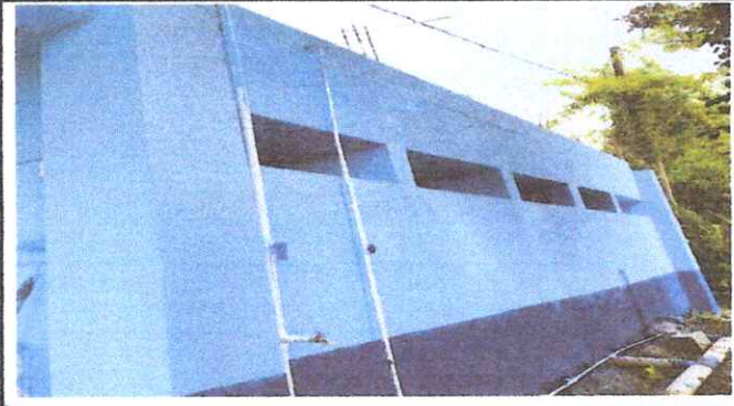
FOTO 1: IMPERMIABILIZACIÓN DE LOSA Y PAREDES.
