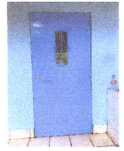
FOTO 4: Mantenimiento a estructura (lijado, cambio de tubo, cepillado, sujeciones, aplicación de pintura)
