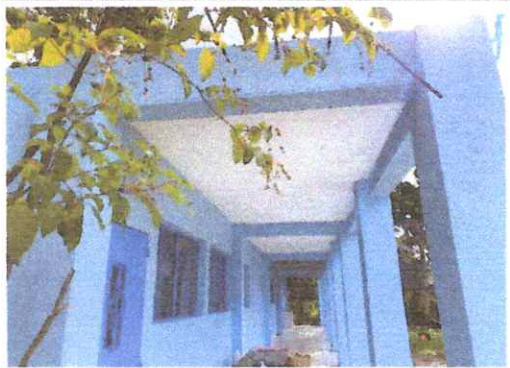
FOTO 2: Pintura en Muros Exteriores e Interiores.
