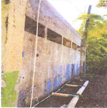
Foto1: IMPERMEABILIZACIÓN DE LOSA Y PAREDES.
