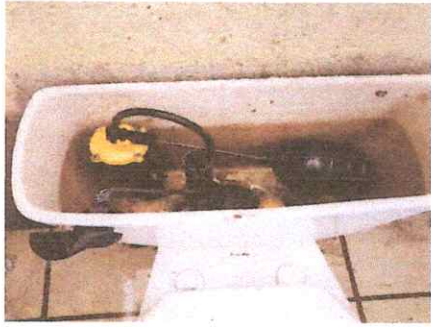
FOTO 7: Sustitución de Accesorios Inodoro (contra llave, tubo de abasto y tanque)
