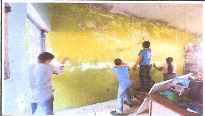
FOTO 2: Pintura en Muros Exteriores e Interiores.
