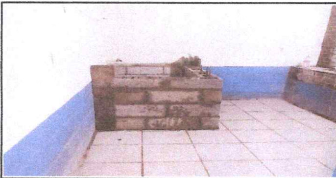
FOTO 5: Sustitución de pila de cemento de un lavadero.
