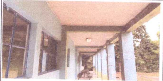
FOTO 2: Pintura en muros exteriores e interiores
