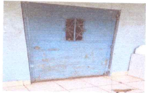
FOTO 4: Mantenimiento a estructura (lijado, cambio de tubo , cepillado, sujeciones, aplicación de pintura)
