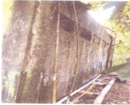
FOTO 1: IMPERMEABILIZACION DE LOSA Y PAREDES
