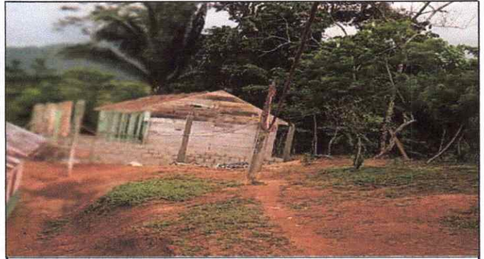
Foto 2: Cambiando el techo de la escuela.
