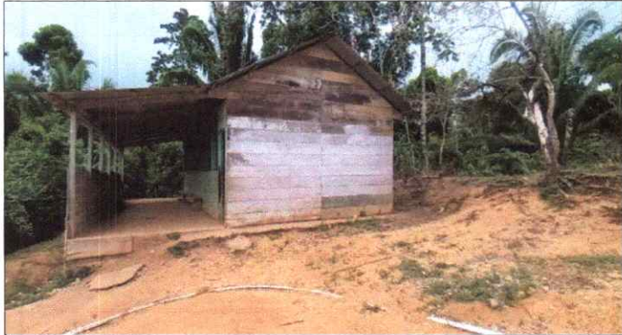
Foto 3: Lado izquierdo de la escuela con aberturas.
