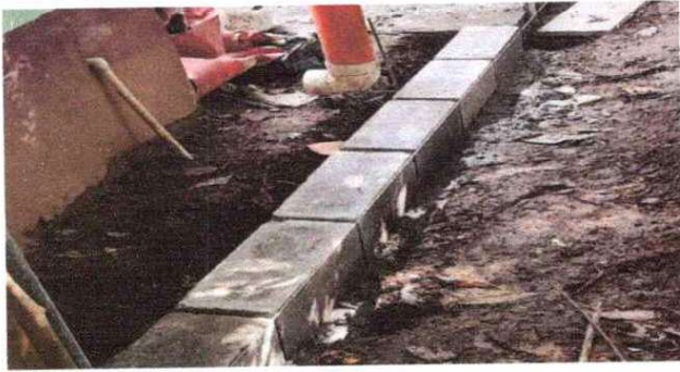
REPARACION DE MURO PERIMETRAL DE BLOCK CON TUBO HG Y Malla GALVANIZADA
