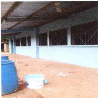
FOTO 5: PINTURA EN MURO EXTERIOR
