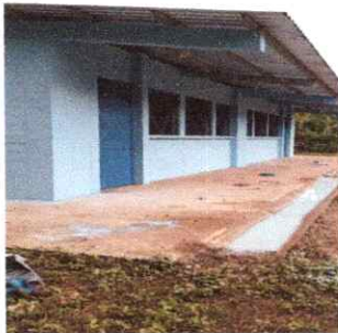
FOTO 3: PINTURA EN MURO EXTERIOR
