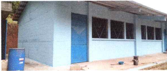
FOTO 1: PINTURA EN MURO EXTERIOR
