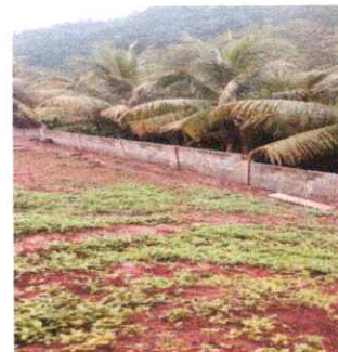
FOTO 6: REPARACION DE MURO DE CONTENCIÓN
