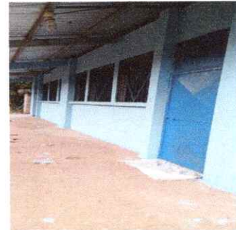
FOTO 4: PINTURA EN MURO EXTERIOR
