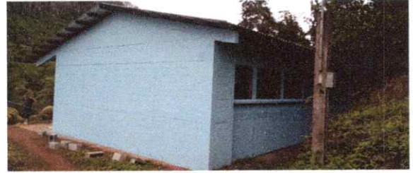
FOTO 2: PINTURA EN MURO EXTERIOR
