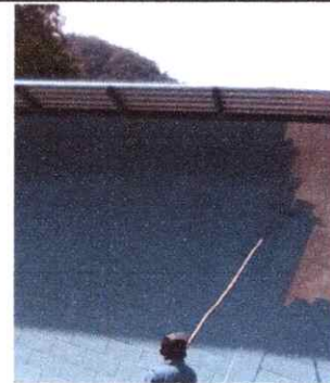
FOTO 2: PINTURA EN MURO EXTERIOR
