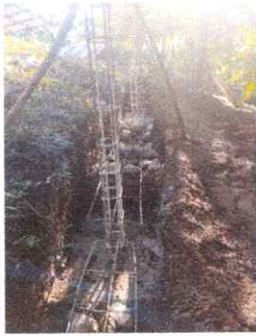
FOTO 7: REPARACION DE MURO DE CONTENCIÓN
