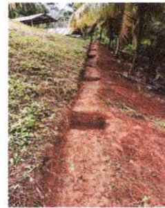
FOTO 4: REPARACION DE MURO DE CONTENCIÓN
