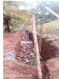
FOTO 6: REPARACION DE MURO DE CONTENCIÓN
