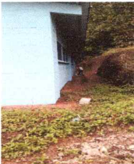
FOTO 3: PINTURA EN MURO EXTERIOR
