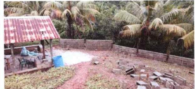
FOTO 12: REPARACION DE MURO DE CONTENCIÓN
