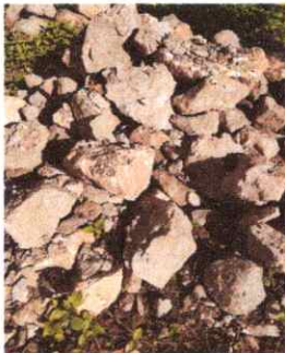
FOTO 5: REPARACION DE MURO DE CONTENCIÓN
