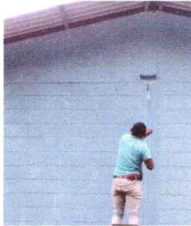
FOTO 1: PINTURA EN MURO EXTERIOR
