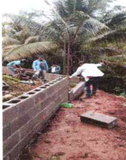
FOTO 11: REPARACION DE MURO DE CONTENCIÓN
