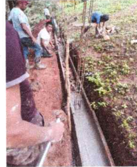
FOTO 8: REPARACION DE MURO DE CONTENCIÓN
