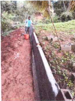
FOTO 9: REPARACION DE MURO DE CONTENCIÓN
