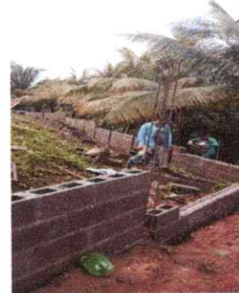
FOTO 10: REPARACION DE MURO DE CONTENCIÓN
