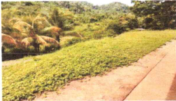
Foto 3: Reparación de muro de contención
