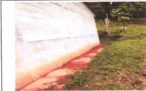
Foto1: Reparación de planchas de concreto de patio
