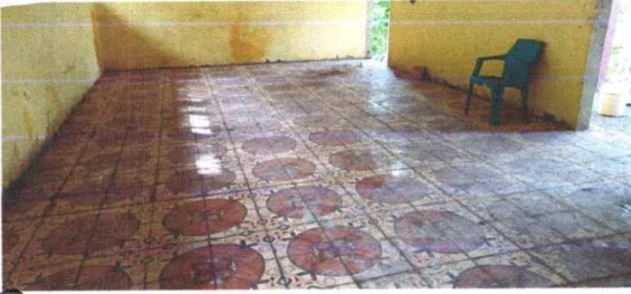
SE APRECIA UN PISO CERAMICO DONDE SUSTITUYE LA TORTA DE CEMENTO CON MUCHOS OYOS QUEDANDO PISO CERAMICO
