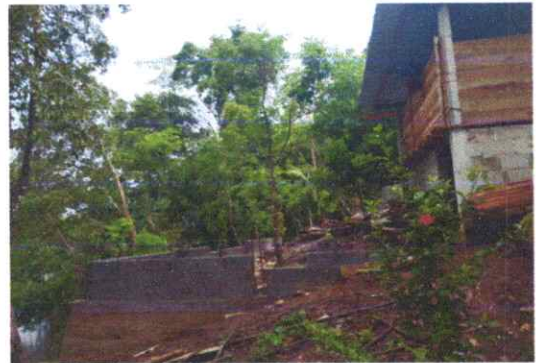
DE ESTA MANERA QUEDA EL MURO DE CONTENCION
