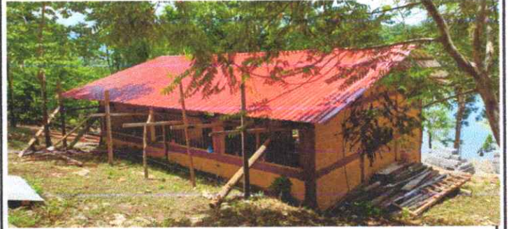
ASI SE APRECIA LA SUSTITUCION DE LAMINAS OXIDADAS POR LAMINAS TROQUELADAS
