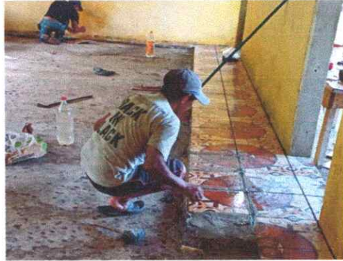
SE OBSERVA LA SUSTITUCION DE TORTA DE CEMENTO POR PISO CERAMICO
