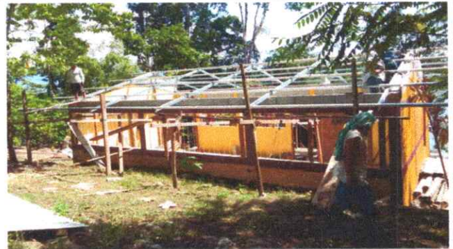
LA SUSPECCION DE ESTRUCTURA DE MADERA POR ESTRUCTURA METALICA
