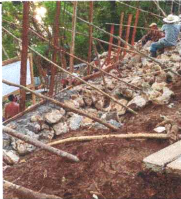
LOS TRABAJOS EN UN PROCESO, ESTE ES EL MURO DE CONTENCION QUE COMUNICA CON UNA PEQUEÑA BODEGA
