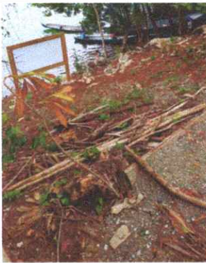
SE OBSERVA QUE EL SUELO ESTÁ MUY INCLINADO Y CON EL TIEMPO SE IRÁ LAVANDO LOS CIMIENTOS
