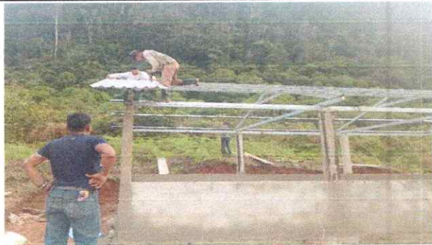
Foto 1: INSTALACIÓN DE LÁMINA TROQUELADA CALIBRE 26
