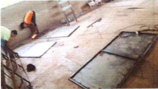
Foto 3: ELABORACIÓN DE PUERTA DE METAL
