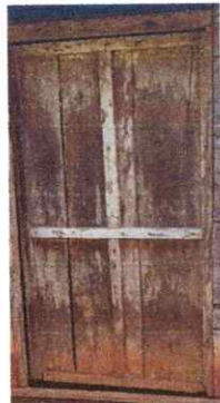
Foto 3: Sustitución de puerta de madera, por metal
