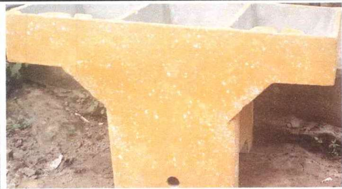
Sustitución de pila de cemento de dos lavadero
