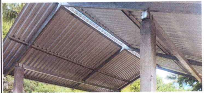
Sustitución de estructura de soporte de madera, por metal (cocina)
