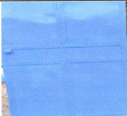
sustitución de puerta de madera por metal (cocina)
