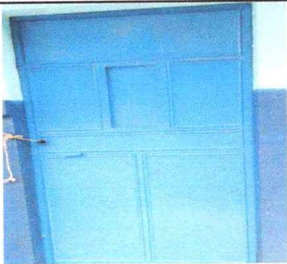
Sustitución de Puerta del (aula)
