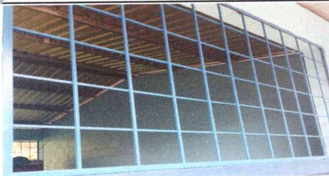
Mantenimiento a balcones de metal
