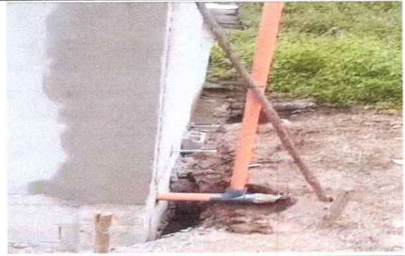
Limpieza de Fosa Séptica
