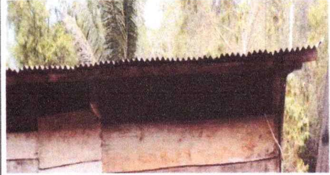
Sustitución de estructura de soporte de madera, por metal COCINA
