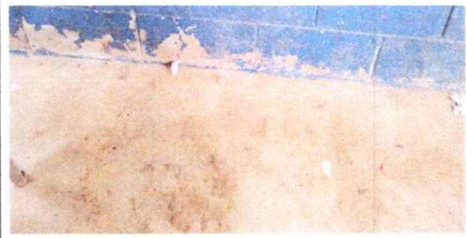
Sustitución de piso de torta de concreto
