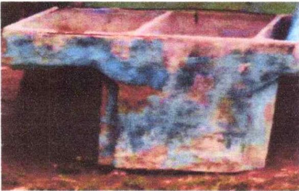
Sustitución de pila de cemento de dos lavadero
