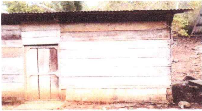
Sustitución de lámina, por lámina troquelada aluzinc calibre 26 COCINA
