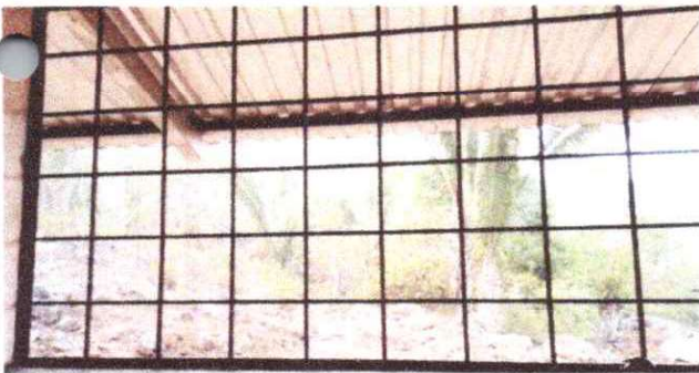
Mantenimiento a balcones de metal
