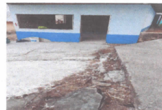
SUSTITUCION DE PUERTA
