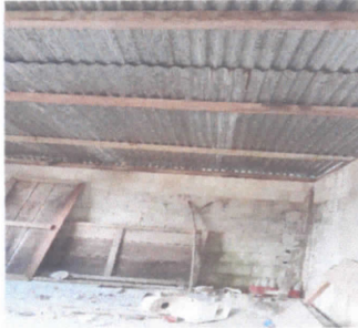
SUSTITUCION DE LAMINA
