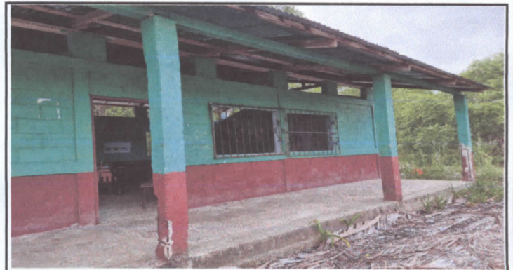
REPARACIÓN DE LAS BASES DEL CORREDOR DE LAS AULAS
