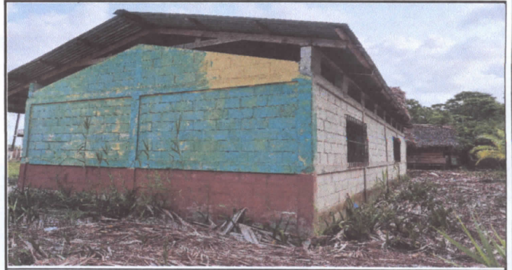
CAMBIO DE PINTURA EXTERIOR DE LAS AULAS
