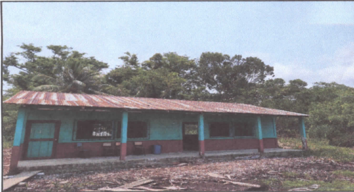
SUSTITUCION DE TECHO
