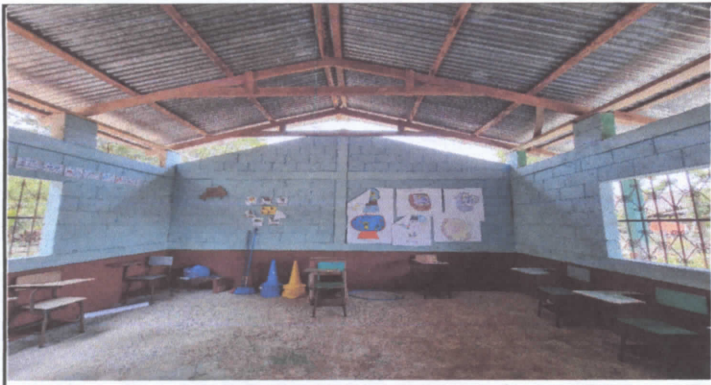
SUSTITUVION DE PISO Y PINTURA INTERIOR DE AULAS
