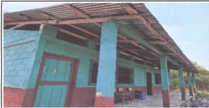
SUSTITUCION DE ESTRUCTURA DEL TECHO
