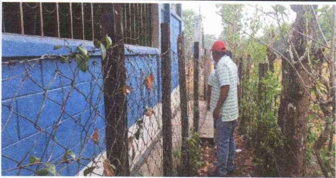
Foto1: Reparación de muro perimetral de block con tubo hg y malla galvanizada, soleras intermedias
