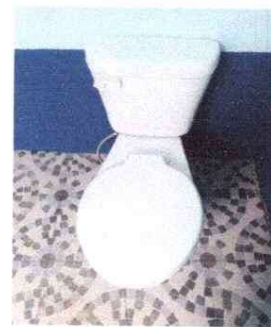
Sustitución de taza para baño
