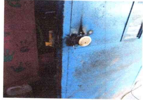
Sustitución de chapa para puertas
