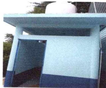
Sustitución de pared para baño
