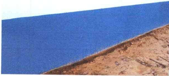
Sustitución de simiento
