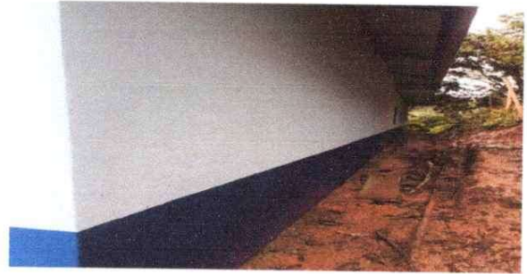
Sustitución de pared
