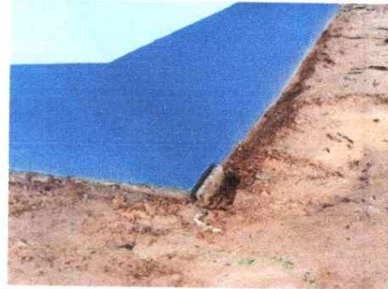
Sustitución de columnas
