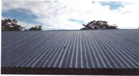
sustitución de laminas
