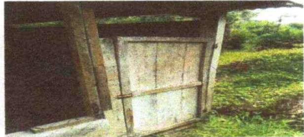
Sustitución de pared para baño
