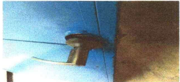
Sustitución de chapa para puertas
