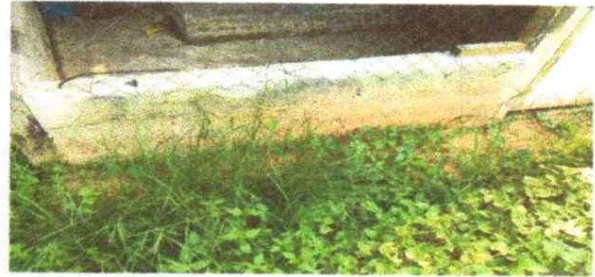
Sustitución de pared
