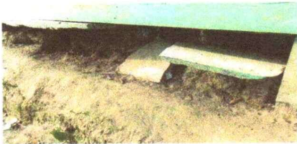
Sustitución de muro de contención
