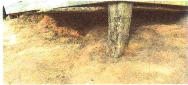
Sustitución de columnas
