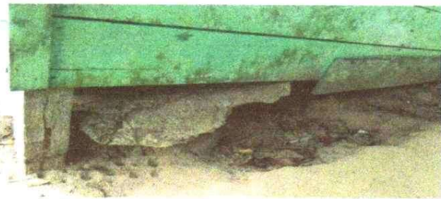
Sustitución de simiento y biga de humedad
