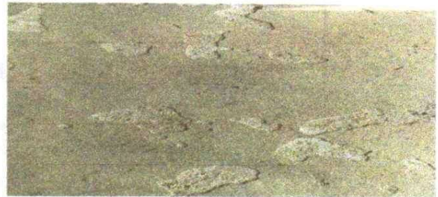
Sustitución de piso
