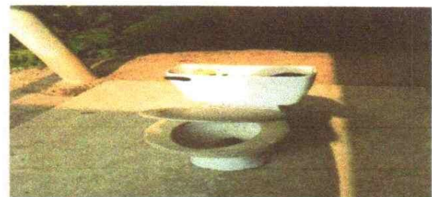
Sustitución de taza para baño
