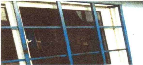
Sustitución de balcones
