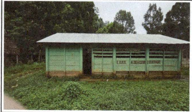
Foto 2: REMOZAMIENTO DE AULA
