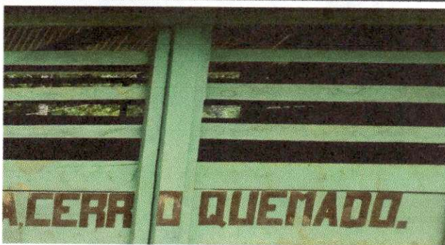
Foto 5: REMOZAMIENTO DE MUROS DE AULA
