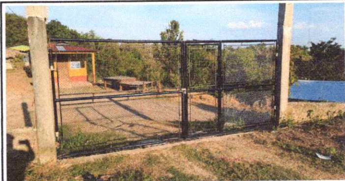
FOTO 8: Fabricación e Instalación de Porton de metal de entrada....
