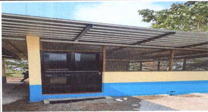
FOTO 1: Sustitución de lámina, por lamina troquelada aluzinc calibre 26
