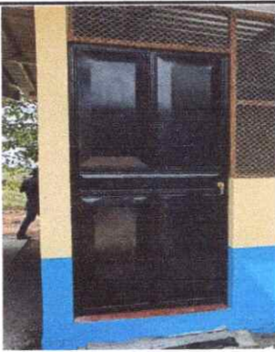
FOTO 3: SUSTITUCIÓN DE PUERTA
