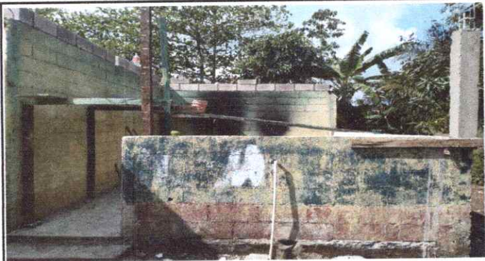
FOTO 1: Sustrucción de lámina, por lamina troquelada aluzinc calibre 26
