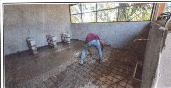
FOTO 5: Sustrucción de piso de cemento líquido
