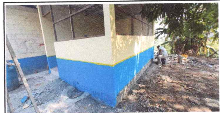
FOTO 6: Repello y pintura exterior e interior
