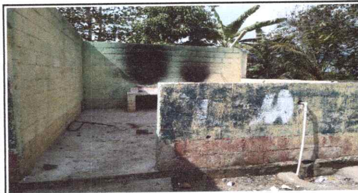
FOTO 3: Sustrucción de puerta
