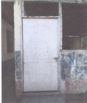
FOTO 3: SUSTITUCIÓN DE PUERTA
