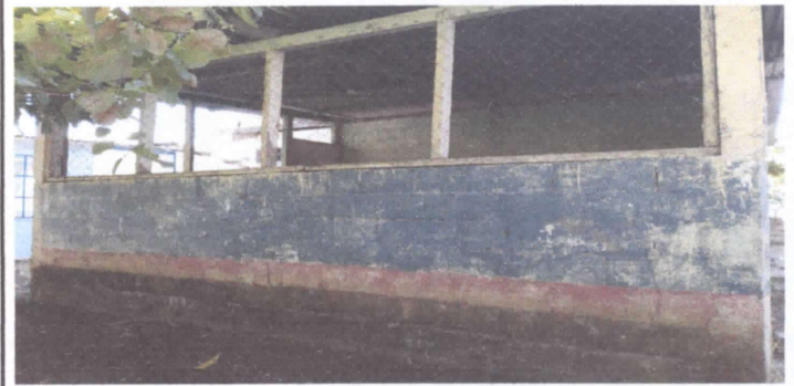
FOTO 4: Sustitución de estructura de metal de ventana
