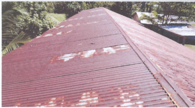
Sustitucion de lamina de Alusin
