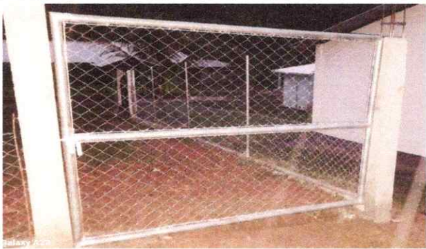
3. PORTON DE TUBO GALAVANZADO INSTALADO
