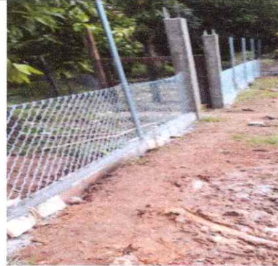
2. TUBO Y MALLA GALVANIZADO INSTALADO
