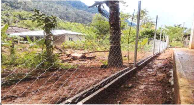
1. BLOCK INSTALADO Y MALLA
