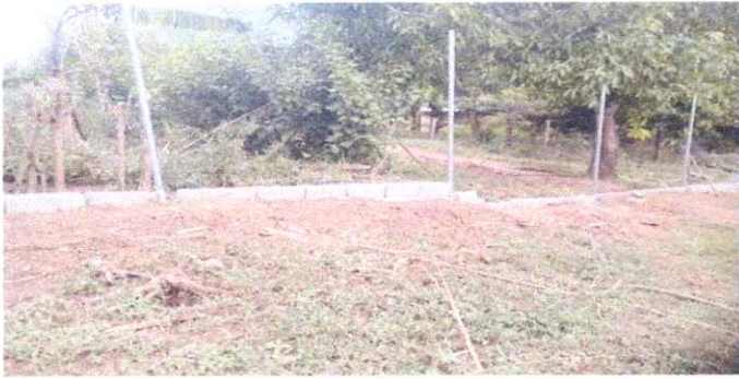
3. COLOCACIÓN DE TUBO GALVANIZADO Y MALLA
