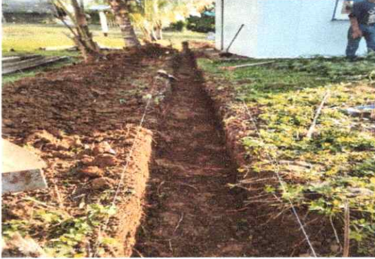
1. SANJEANDO PARA EL MURO PERIMETRAL
