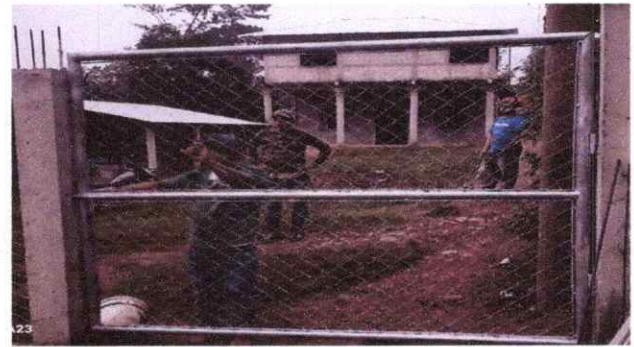
4. INSTALANDO PORTON DE TUBO GALVANIZADO
