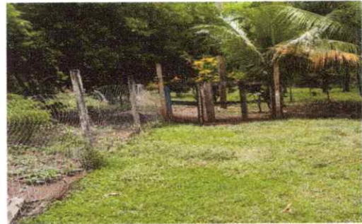
Foto 2: Reparación de muro perimetral de block con tubo hg y malla galvanizada, soleras intermedias y columnas.
