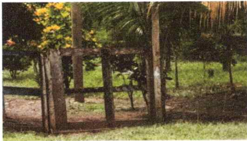
Foto 3: Sustitución de portón de metal
