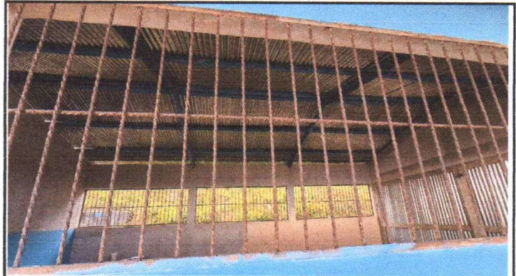
FOTO 2: Fabricación e instalación de balcones de hierro en ventanas.
