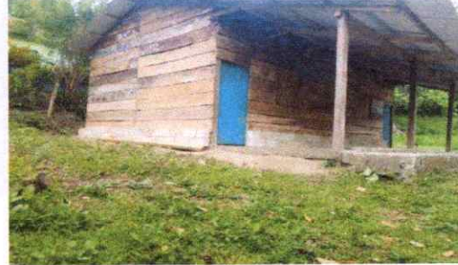
Pintura en exteriores e interiores.
