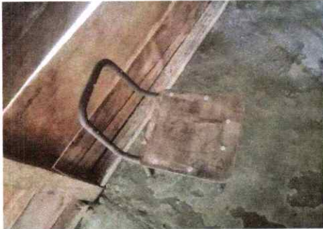
Sustitución de piso de cemento líquido.
