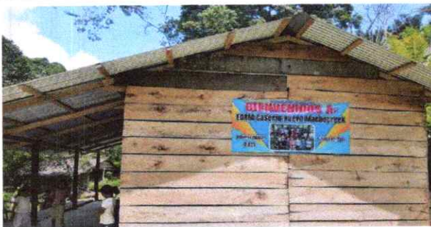
Sustitución de lámina por lámina troquelada.
