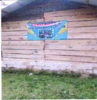
Reparación de pared, ampliación del muro y repello.
