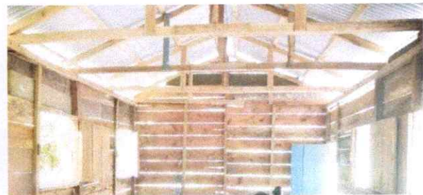
Sustitución de estructura de soporte de madera por metal.
