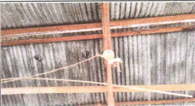
FOTO 3: Sustitución de focos ahorradores
