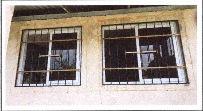
sustitución de Balcones de metal y ventanas
