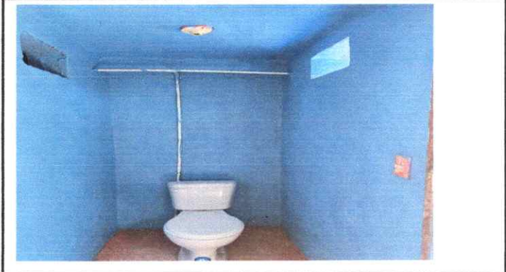
Mantenimiento a infraestructura de servicios sanitarios y accesorios
