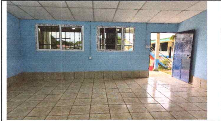
Sustitución de balcones de metal y ventanas
