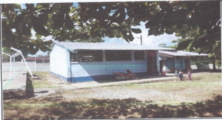
Sustitución de lámina por lámina troquelada Alizinc calibre 26
