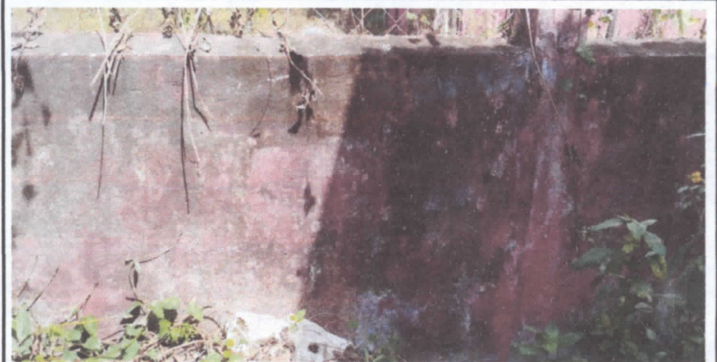
FOTO 4: Pintura en muros exteriores e interiores
