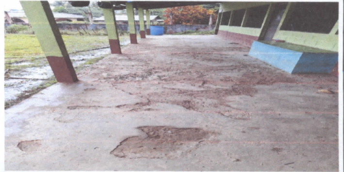
FOTO 2: Reparación de piso de torta de concreto
