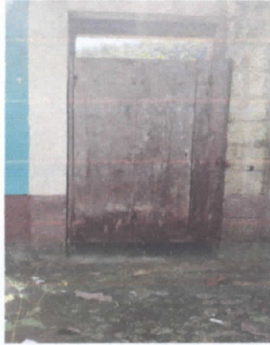
FOTO 1: SUSTITUCIÓN DE PUERTA DE MADERA POR METAL
