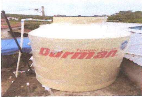
Foto 3: Sustitución de deposito de agua 1100 litros.
