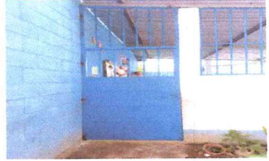
Foto 2: Colocación de puerta de metal módulo 1
