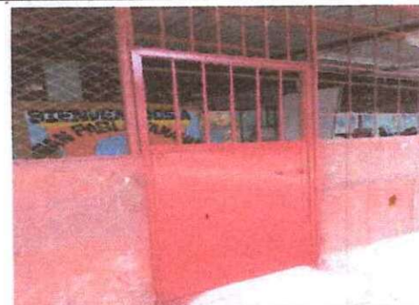
Foto 6: Colocación de puerta en Módulo 2.
