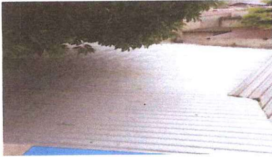
Foto1: Cambio de Lámina por lamina troquelada Aluzinc calibre 26
