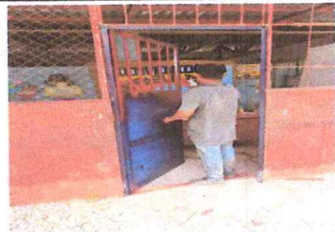
Foto 6: Colocación de puerta en Módulo 2.
