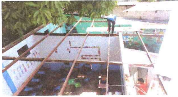
Foto1: Cambio de Lámina por lamina troquelada Aluzinc calibre 26
