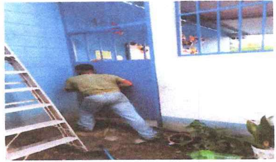
Foto 2: Colocación de puerta de metal módulo 1
