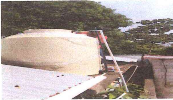
Foto 3: Sustitución de depósito de agua 1100 litros.
