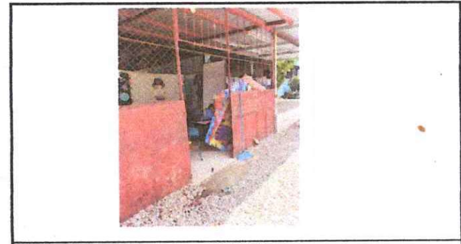
Foto 6: Colocación de puerta en Módulo 2.
