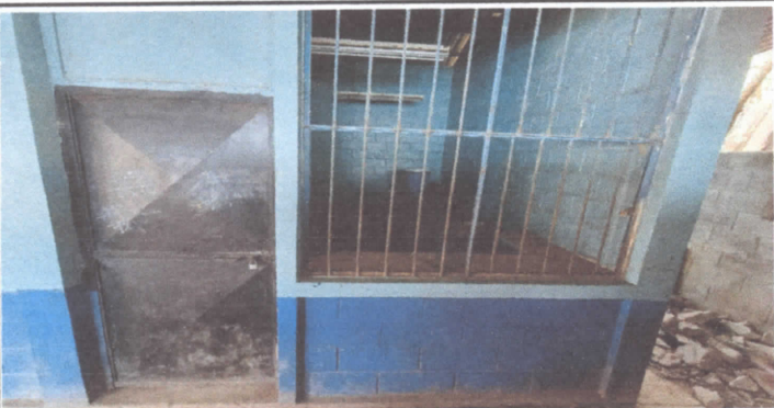
FOTO 3: Sustitución de ventana de metal de ventana.
